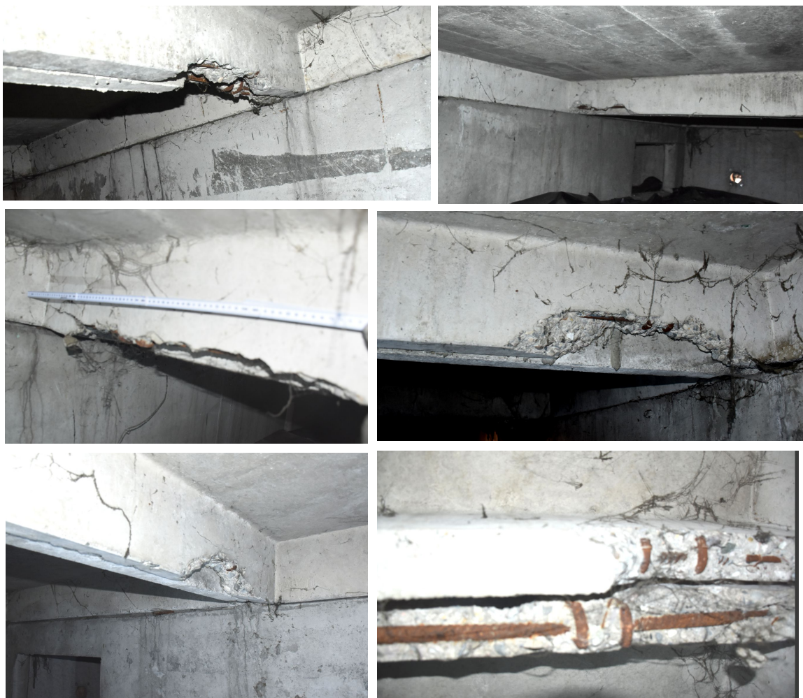
Foto 25 - 29. Inne uszkodzenia płyt korytkowych.
