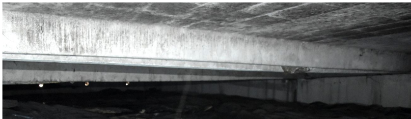
Foto 15 - 18. Nadmierne ugięcie płyt korytkowych nr 2, 14 i 17.
