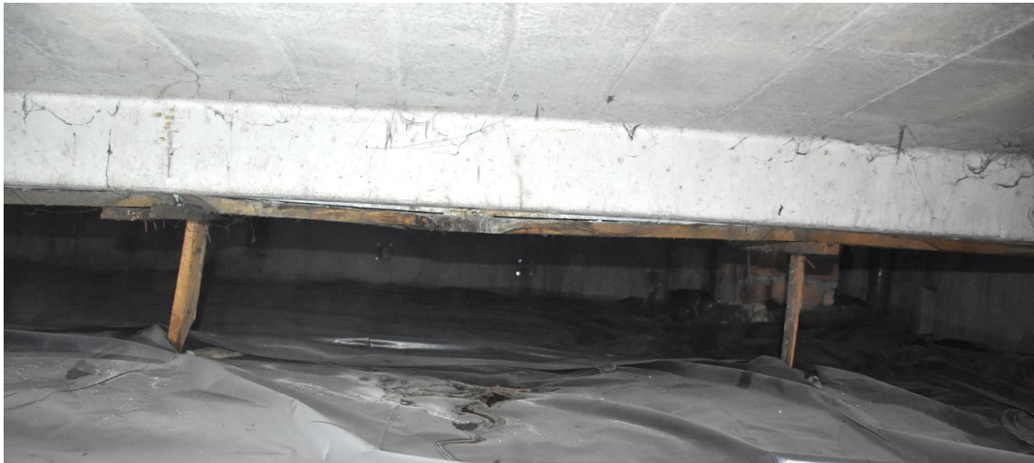
Foto 12 - 14. Miejscowy przeciek z koryta (lewa strona budynku) w strefie obniżenia (niecka).
