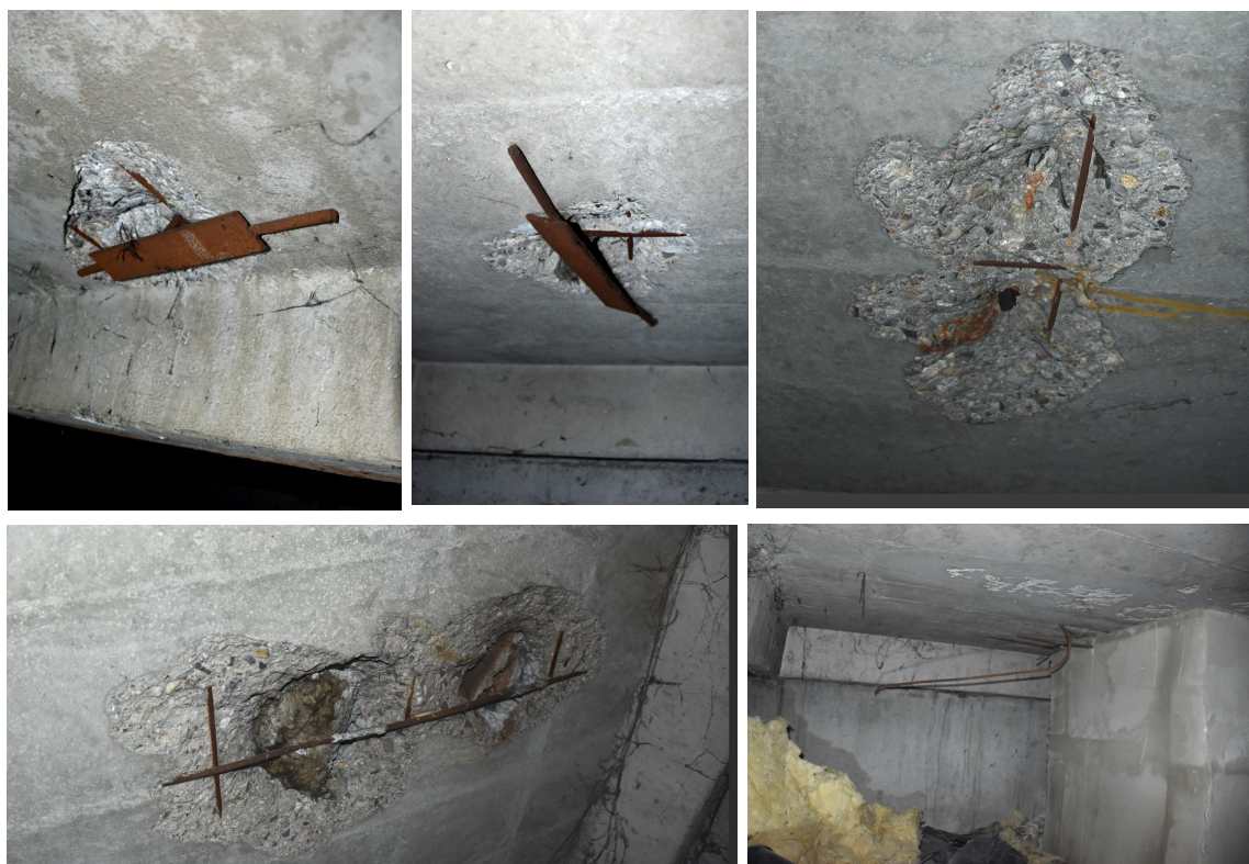
Foto 25 - 29. Inne uszkodzenia płyt korytkowych.
