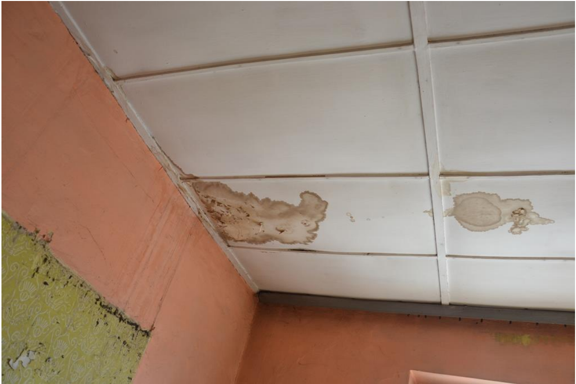
Rys. 41. Zacieki, ślady po zalaniu na stropie w mieszkaniu nr 2 [1.3].
