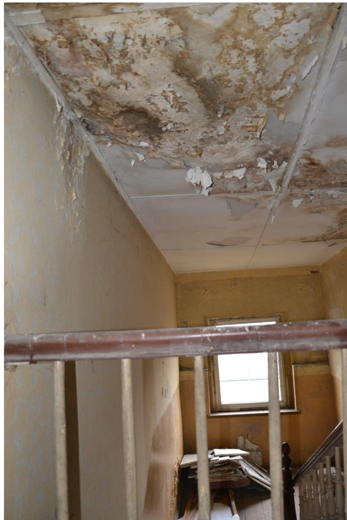
Rys. 35. Ślady zawilgoceń oraz uszkodzona podbitka sufitu w klatce schodowej [1.3].
