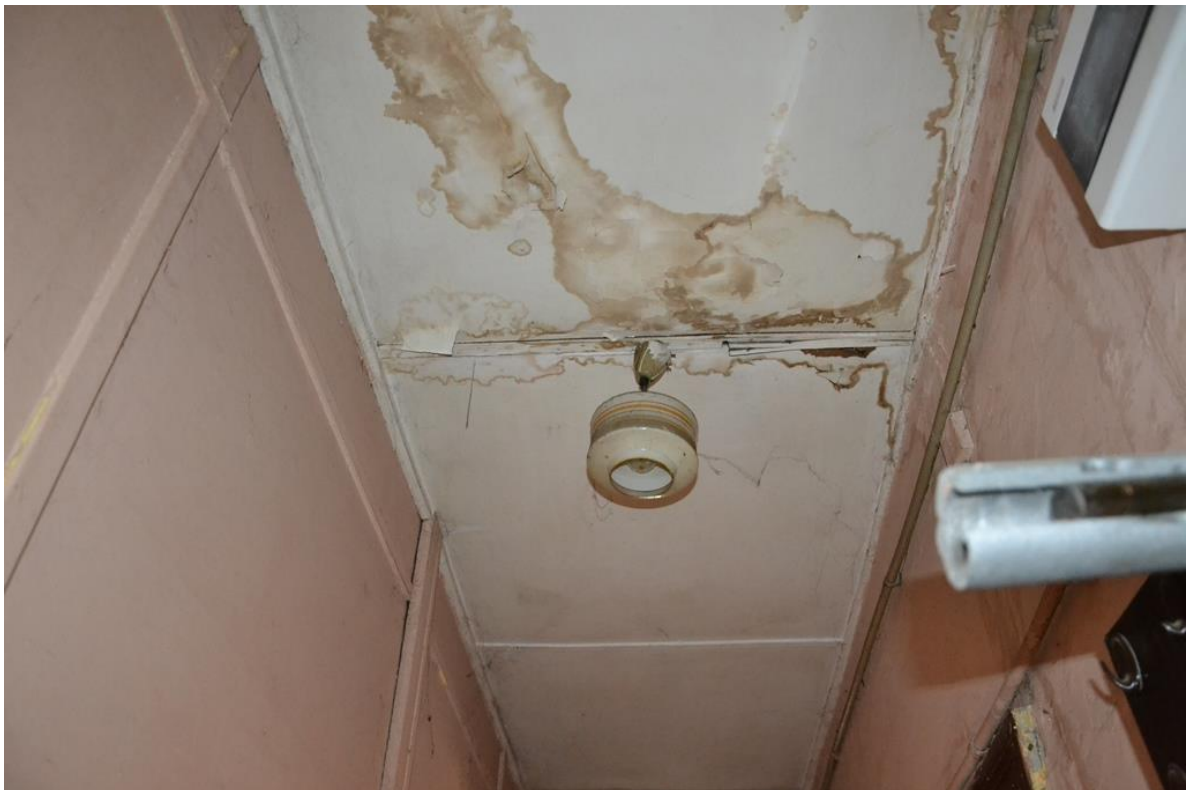
Rys. 40. Zacieki, ślady po zalaniu na stropie w mieszkaniu nr 2 [1.3].
