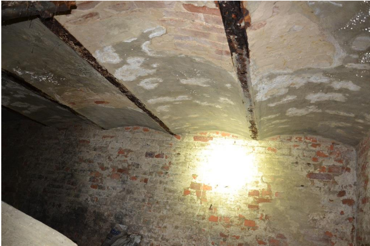
Rys. 28. Ubytki tynku na stropie i ścianach oraz korozja belki stalowej stropu odcinkowego we wschodniej części piwnic [1.3].
