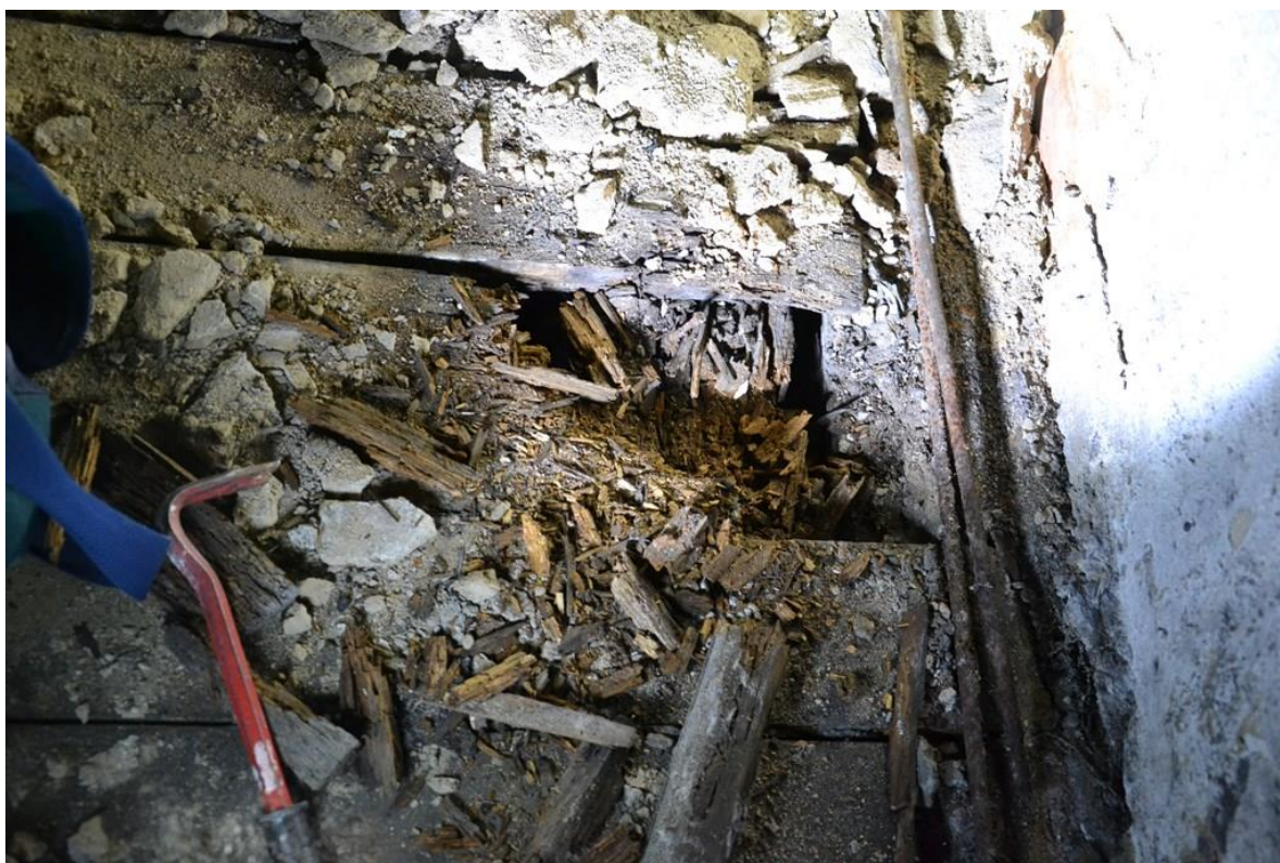
Rys. 57. Uszkodzone (spróchniałe) deski podłogi oraz fragment belki stropowej [1.3].
