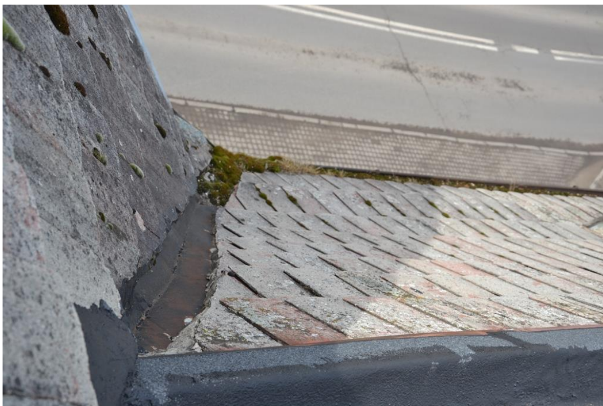
Rys. 61. Zapchane, zanieczyszczone rynny połaci frontowej [1.3].
