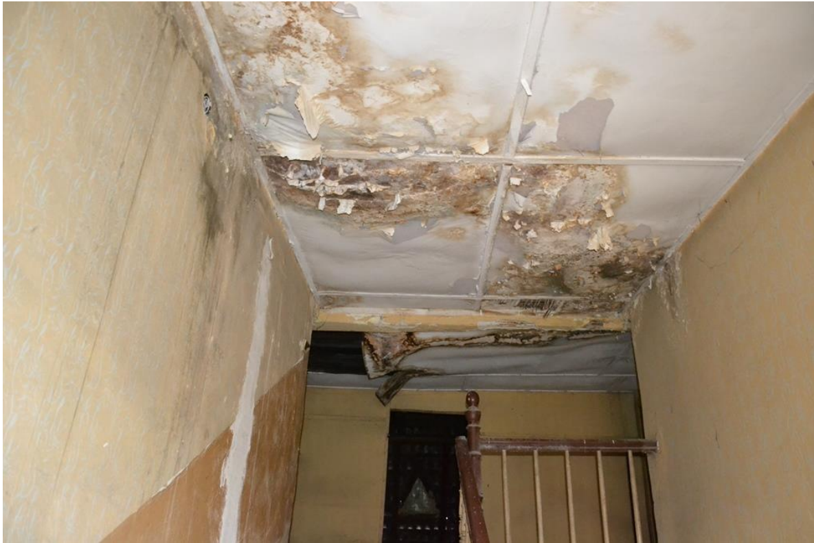
Rys. 36. Ślady zawilgoceń oraz uszkodzona podbitka sufitu w klatce schodowej [1.3].
