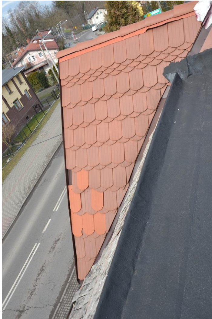
Rys. 62. Luźne dachówki na zadaszeniu lukarny [1.3].
