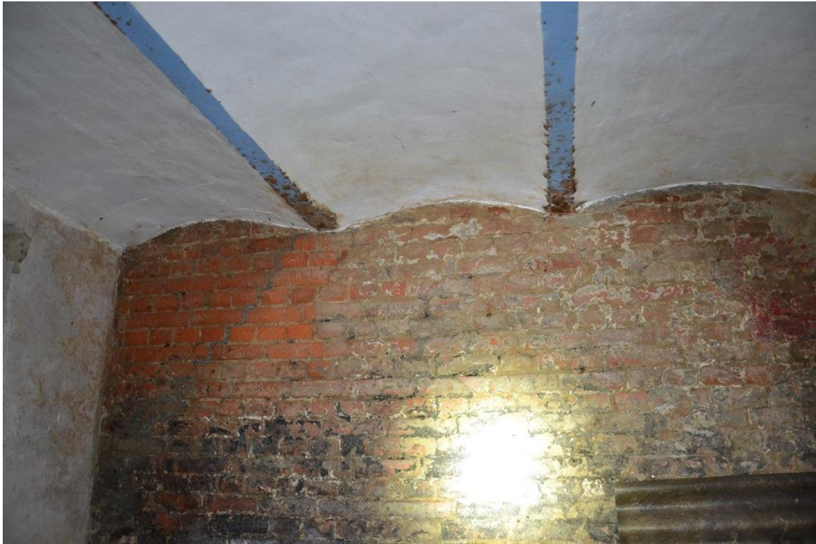
Rys. 26. Ubytki tynku na ścianach oraz początkowa korozja belki stalowej stropu odcinkowego w zachodniej części piwnic [1.3].
