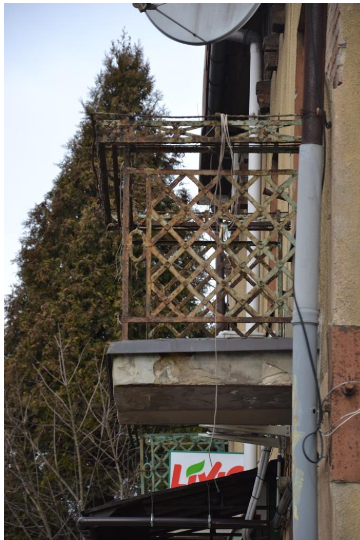
Rys. 70. Korozja stalowej barierki balkonu [1.3].
