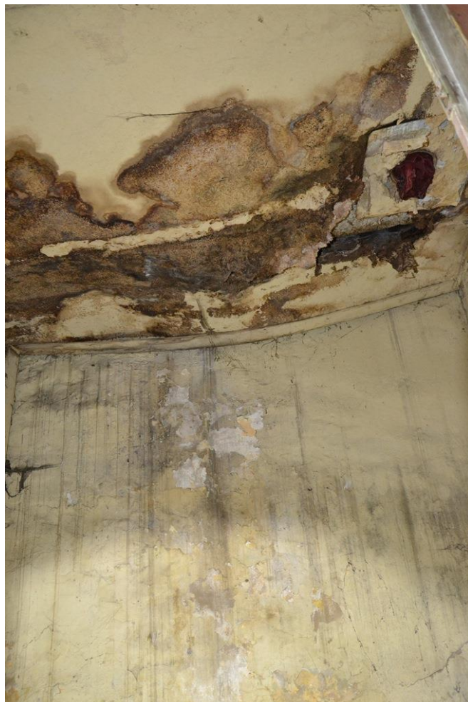
Rys. 53. Zacieki, ślady po zalaniu, uszkodzona podbitka sufitowa w pokoju (strona południowa) na poddaszu [1.3].
