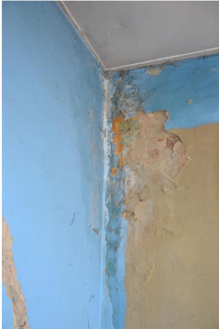
Rys. 43. Zacieki, ślady po zalaniu, ubytki tynku na ścianach w mieszkaniu nr 2 [1.3].
