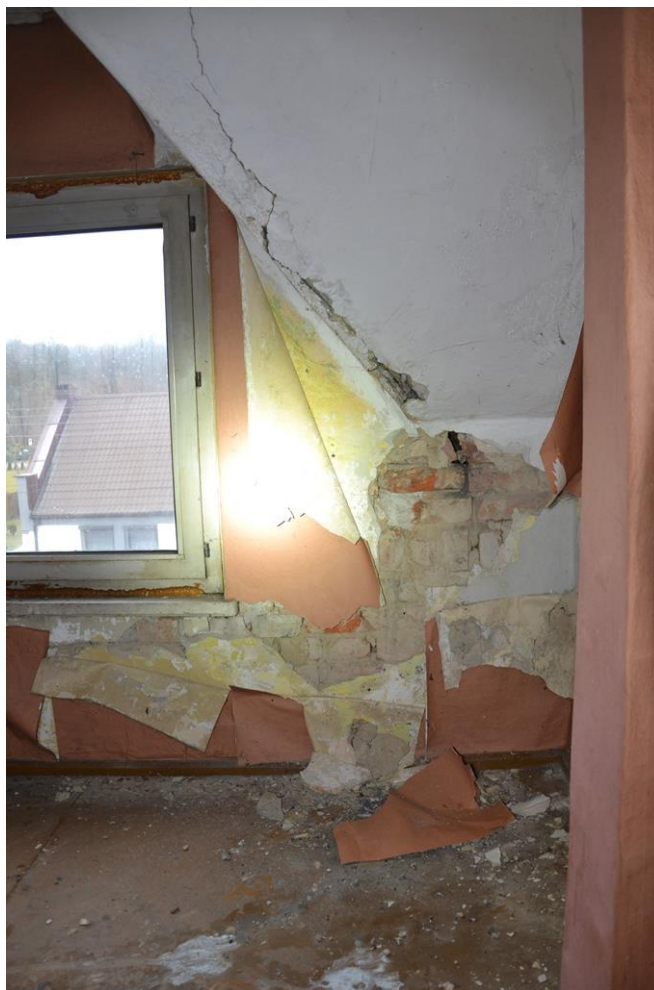
Rys. 54. Uszkodzona podbitka, zarysowania tynku podbitki sufitowej w pokoju (strona południowa) na poddaszu [1.3].
