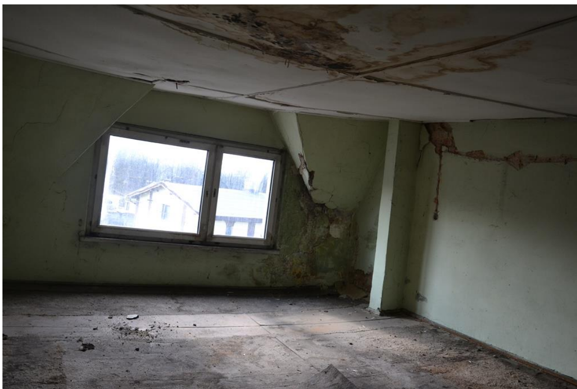
Rys. 49. Zacieki, ślady po zalaniu, uszkodzona podbitka sufitowa, ubytki tynku na ścianach w pokoju (strona północna) na poddaszu [1.3].
