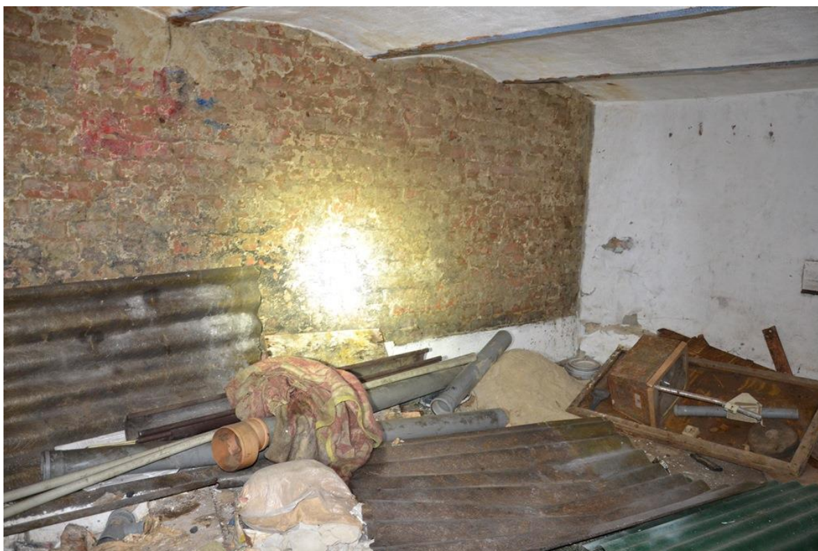
Rys. 25. Ubytki tynku na ścianach, składowisko odpadów w zachodniej części piwnic [1.3].
