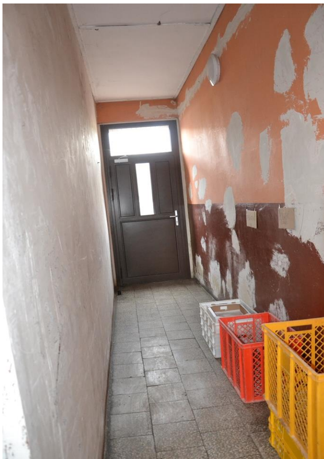
Rys. 32. Uszkodzenia i zabrudzenia powłok malarskich i tynku na ścianach w korytarzu [1.3].
