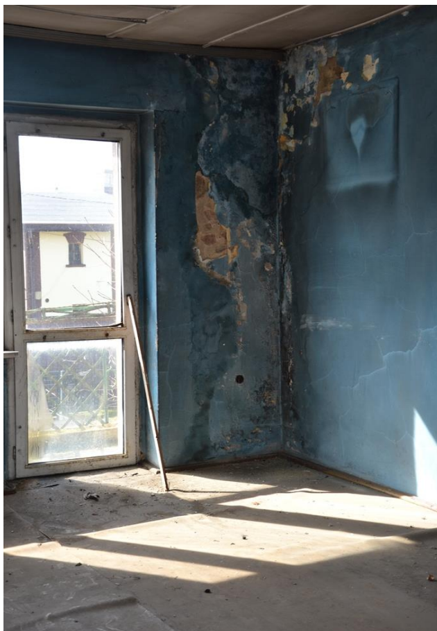
Rys. 45. Zacieki, ślady po zalaniu, ubytki tynku na ścianach w mieszkaniu nr 3 [1.3].
