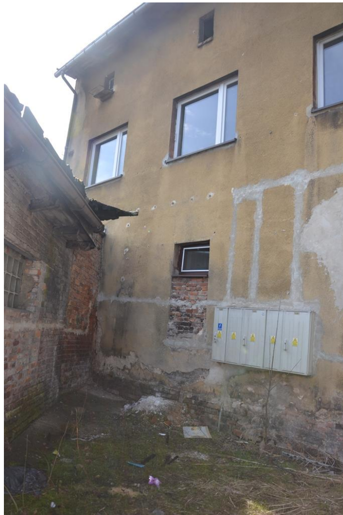
Rys. 67. Ubytki tynku na cokole – elewacja tylna [1.3].
