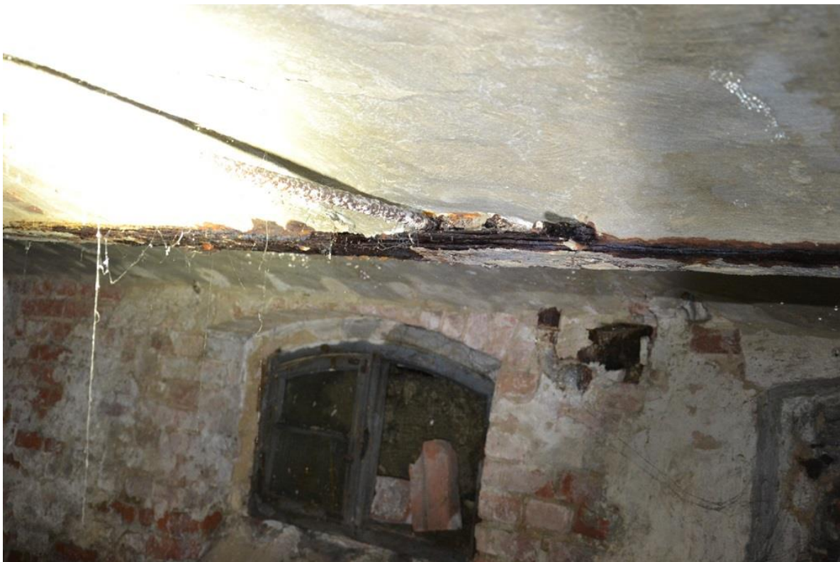
Rys. 29. Korozja belki stalowej stropu odcinkowego we wschodniej części piwnic [1.3].
