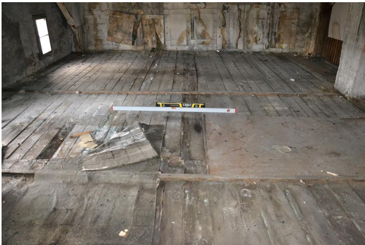
Rys. 56. Ślady zacieków, uszkodzone deski podłogi poddasza [1.3].
