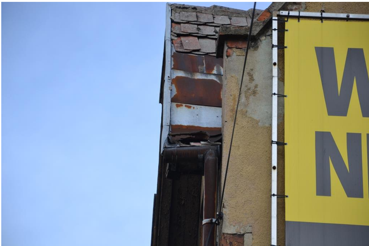
Rys. 63. Luźne dachówki na zadaszeniu lukarny, korozja blach pokrycia [1.3].
