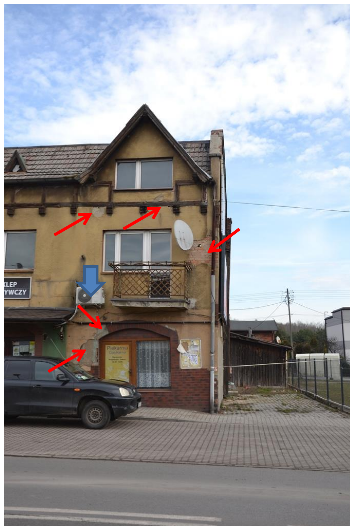
Rys. 64. Ubytki tynku oraz płytek elewacyjnych – elewacja frontowa [1.3].
