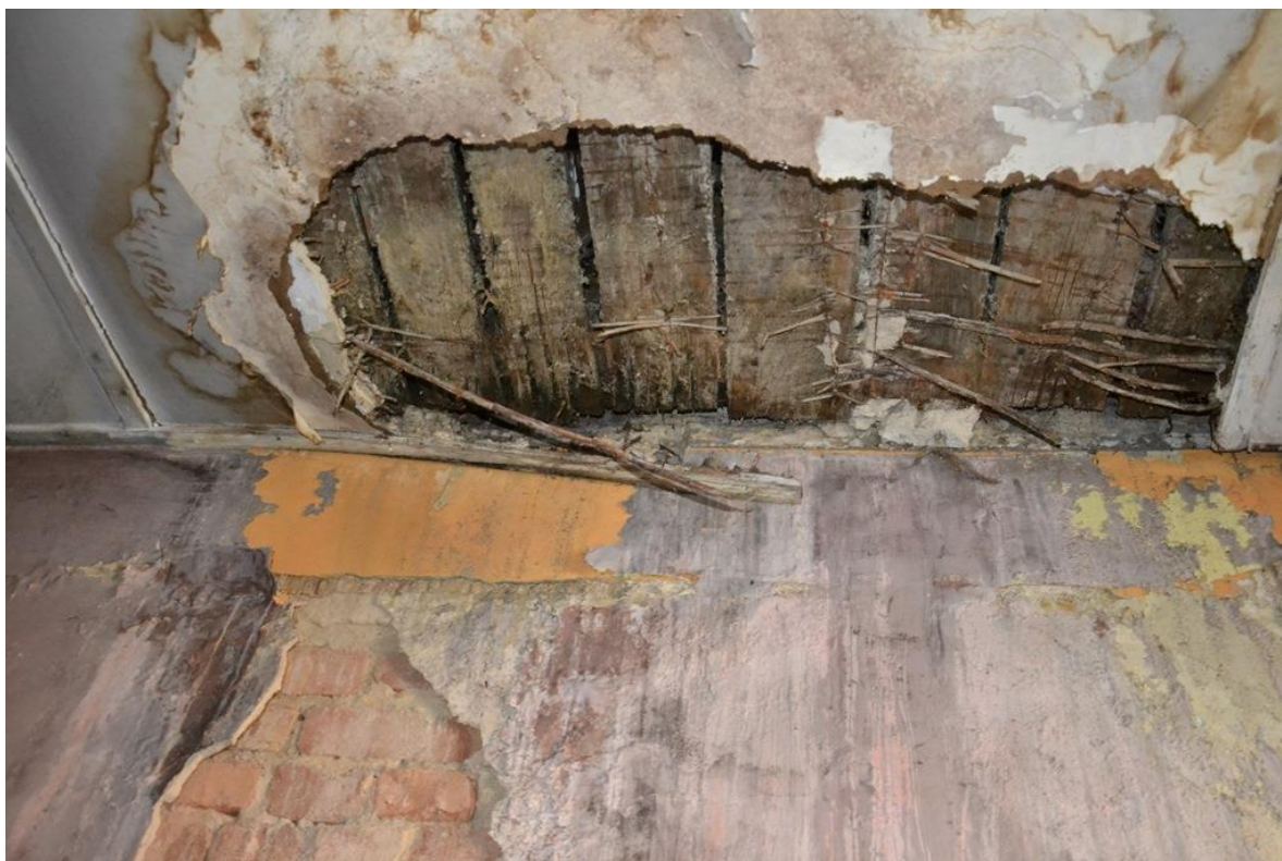
Rys. 48. Zacieki, ślady po zalaniu, uszkodzona podbitka sufitowa, ubytki tynku na ścianach w mieszkaniu nr 3 [1.3].
