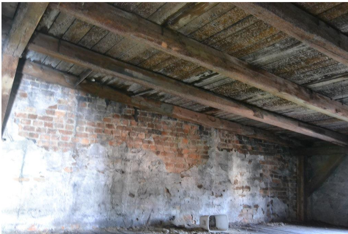
Rys. 60. Ubytki tynku ściany szczytowej, zacieki na elementach więźby powstałe przed remontem pokrycia dachowego [1.3].
