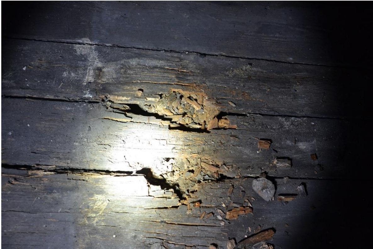
Rys. 58. Uszkodzone (spróchniałe) deski podłogi oraz fragment belki stropowej [1.3].
