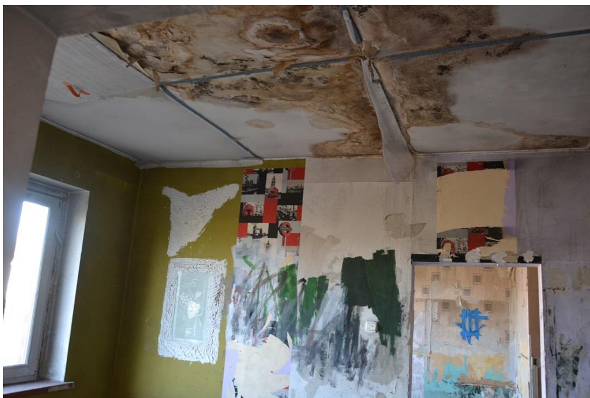
Rys. 38. Zacieki, ślady po zalaniu na stropie w mieszkaniu nr 1 [1.3].
