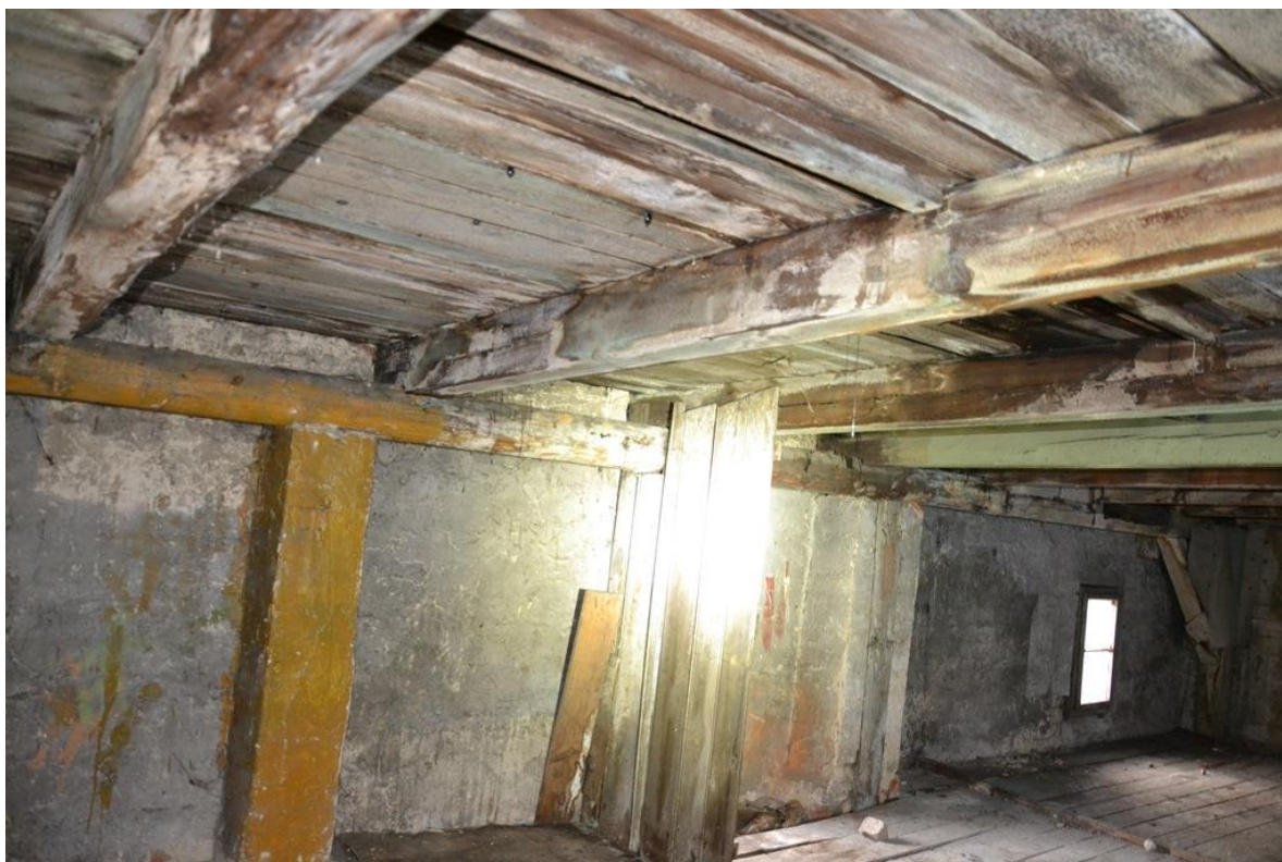
Rys. 55. Ślady zacieków na elementach więźby dachowej [1.3].
