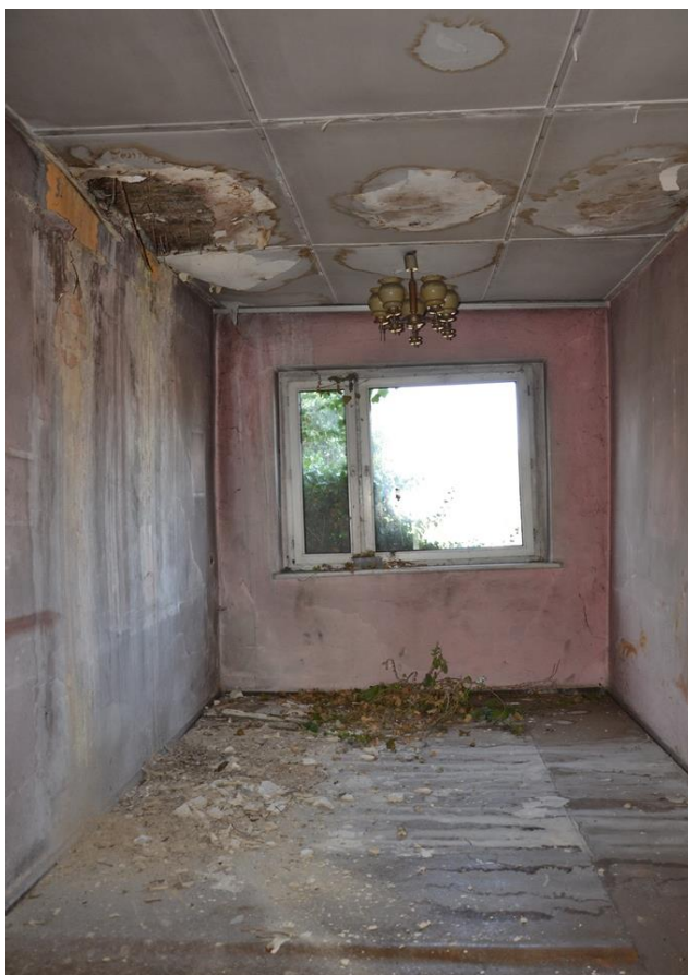
Rys. 46. Zacieki, ślady po zalaniu, uszkodzona podbitka sufitowa, ubytki tynku na ścianach w mieszkaniu nr 3 [1.3].
