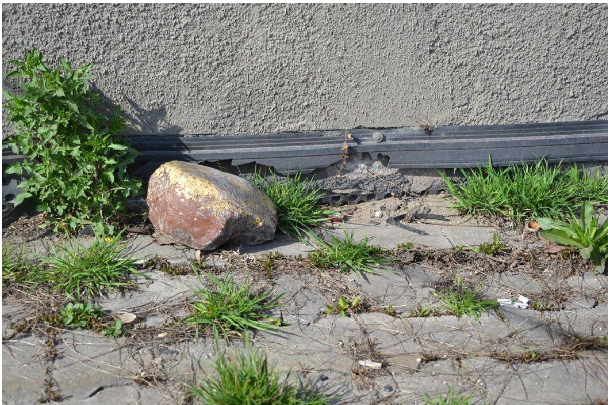
Rys. 68. Listwa dociskowa nie zabezpiecza folii kubelkowej [1.3].
