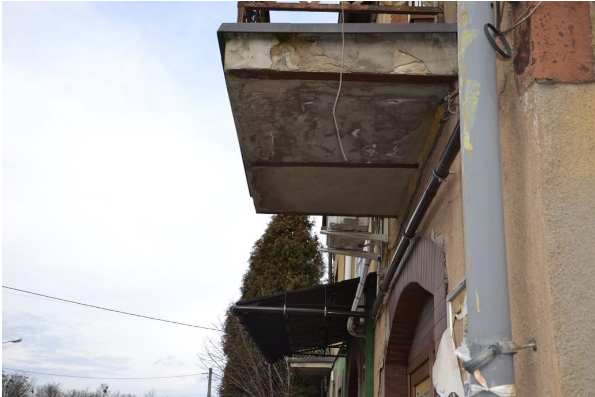
Rys. 69. Ubytki tynku na płytach balkonowych, wysolenia na dolnej krawędzi płyty [1.3].
