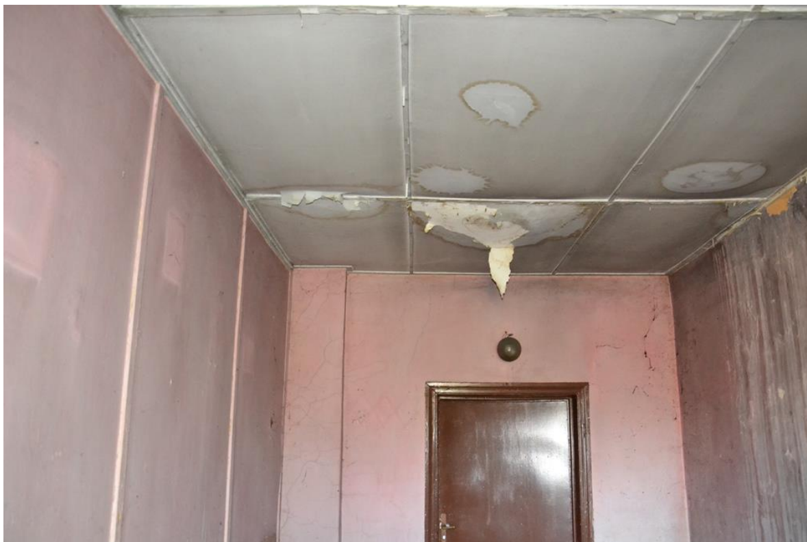
Rys. 47. Zacieki, ślady po zalaniu, uszkodzona podbitka sufitowa w mieszkaniu nr 3 [1.3].
