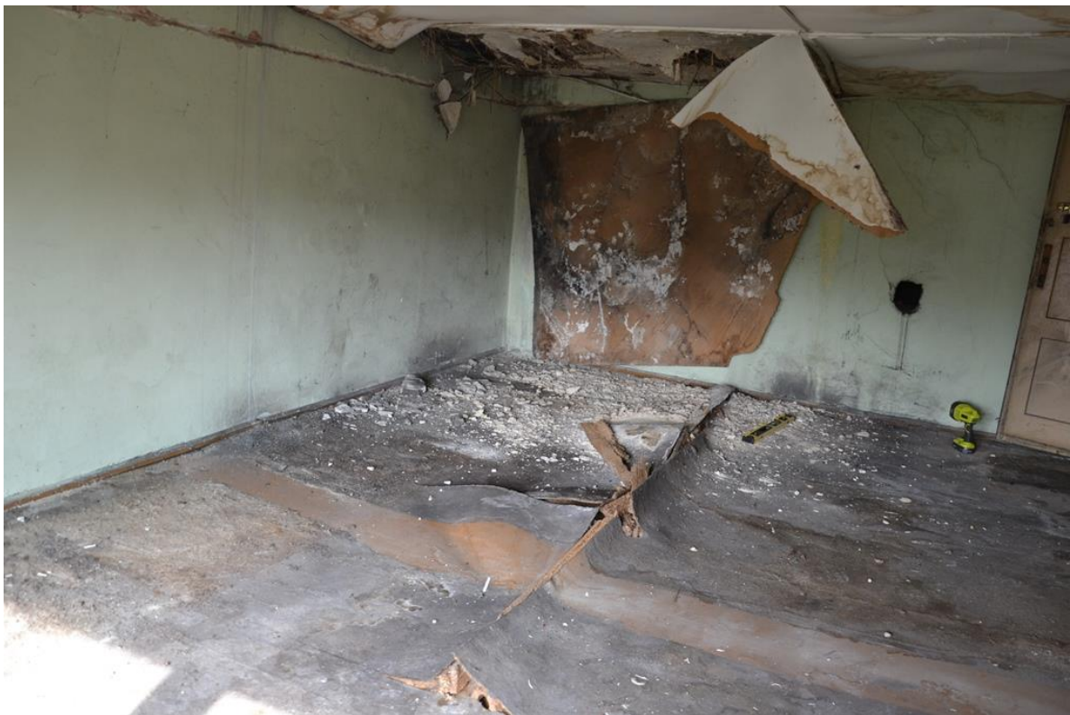
Rys. 51. Zacieki, ślady po zalaniu, uszkodzona podbitka sufitowa oraz warstwy podłogowe w pokoju (strona północna) na poddaszu [1.3].
