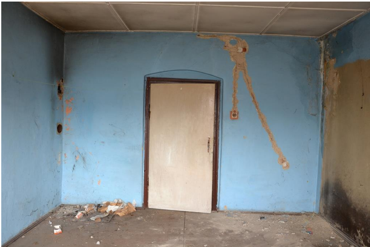
Rys. 42. Zabrudzenia, zużycie techniczne oraz uszkodzenia okładzin w mieszkaniu nr 2 [1.3].
