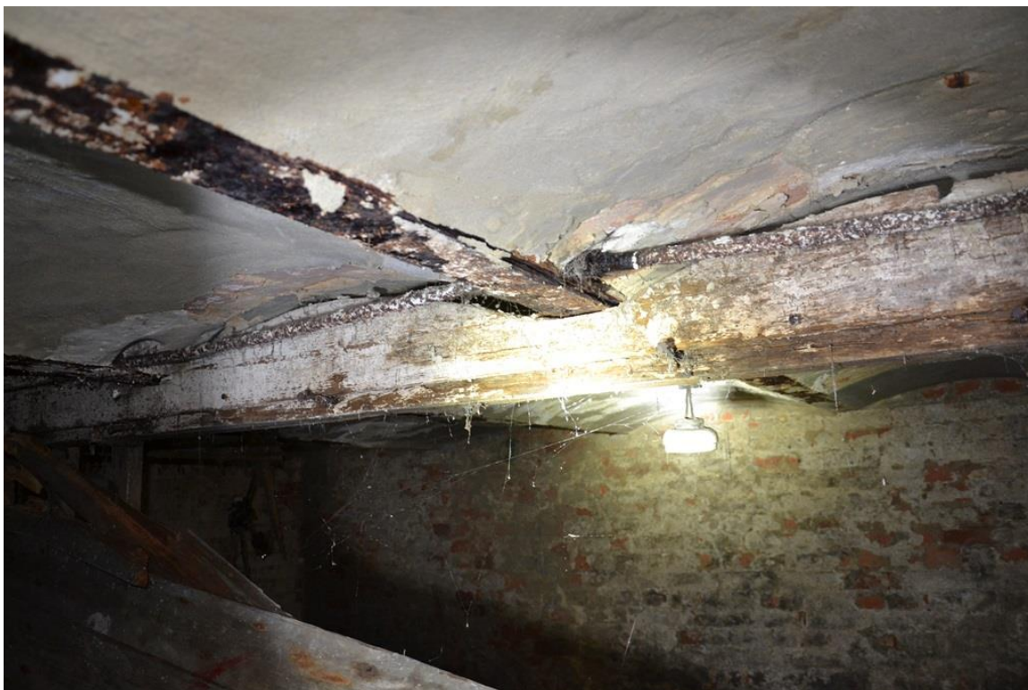
Rys. 30. Korozja belki stalowej stropu odcinkowego we wschodniej części piwnic [1.3].
