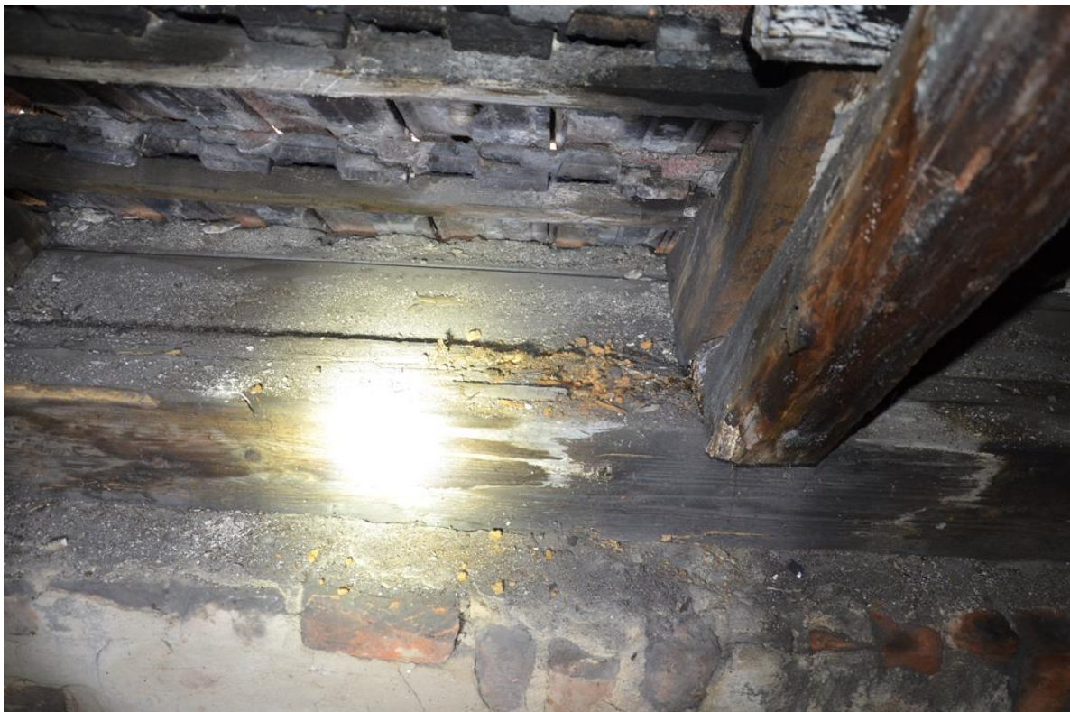
Rys. 59. Uszkodzony (spróchniały) fragment murlaty [1.3].
