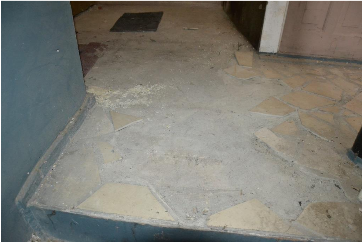
Rys. 34. Uszkodzenia i ubytki warstw podłogowych spocznika na I piętrze. [1.3].
