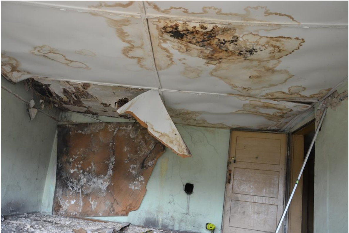
Rys. 50. Zacieki, ślady po zalaniu, uszkodzona podbitka sufitowa w pokoju (strona północna) na poddaszu [1.3].
