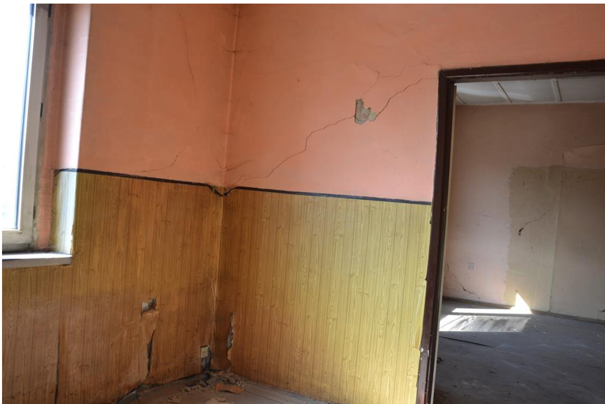
Rys. 44. Zarysowana ściana działowa w mieszkaniu nr 2 [1.3].
