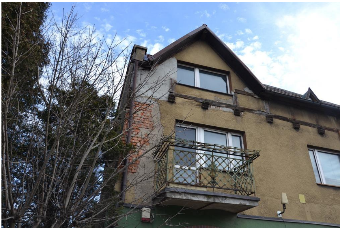
Rys. 65. Ubytki tynku – elewacja frontowa [1.3].
