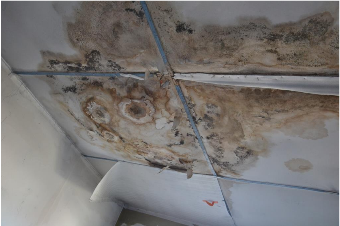
Rys. 39. Zacieki, ślady po zalaniu na stropie w mieszkaniu nr 1 [1.3].
