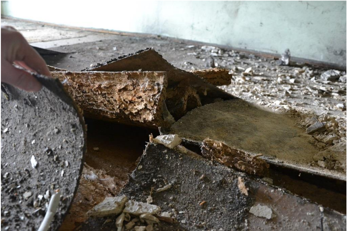
Rys. 52. Ślady po zalaniu, uszkodzone warstwy podłogowe w pokoju (strona północna) na poddaszu [1.3].
